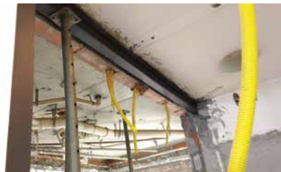
Reforço em perfil metálico W150x18, como solução adotada para reforço estrutural em função da supressão de uma parede.
